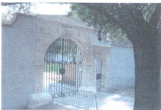
Der vorbildlich renovierte Torbogen der „Alten Hofmühle“
